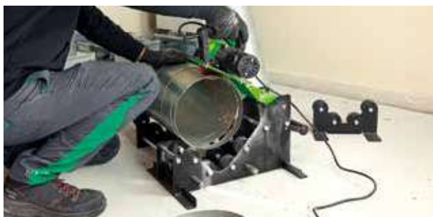
Zeitsparendes Trennen von Lüftungsrohren
